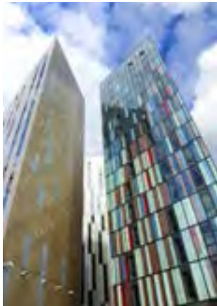
▼ Parkway Gate学生宿舍
